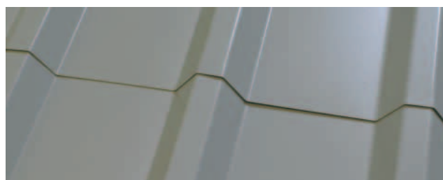
Krawędź cięta na pokryciu dachowym
